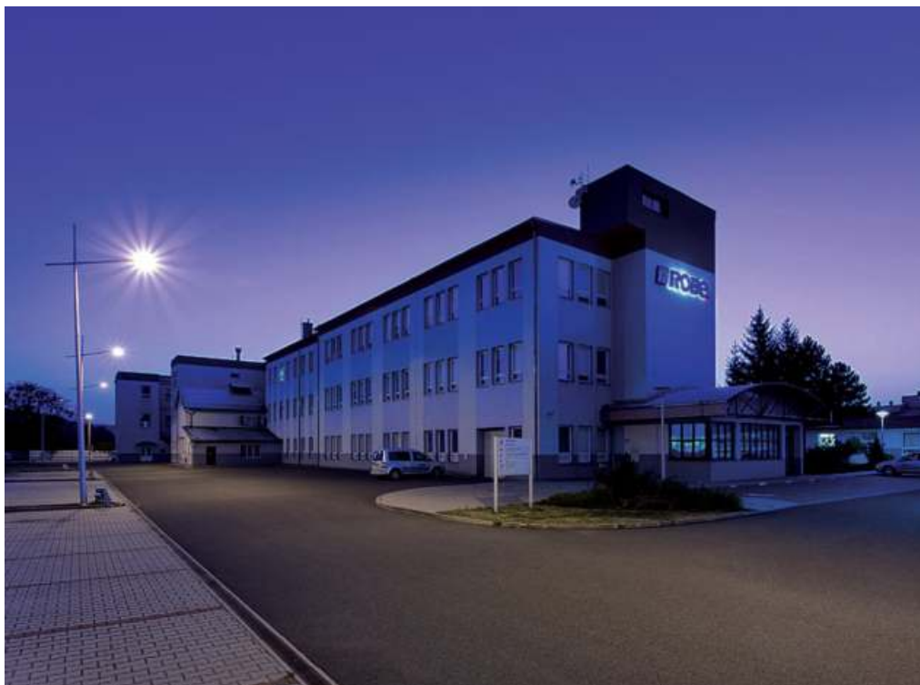
Valašskomeziříčské sídlo firmy ROBE na ulici Palackého (Z fotoarchivu ROBE) ■
